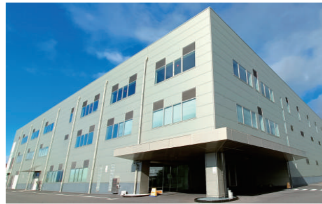
びわこ工場(滋賀県大津市)
